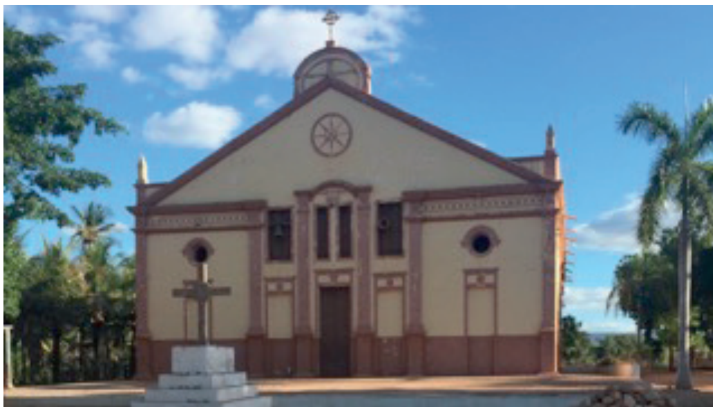
Igreja de Santo Antônio do Toco, em Missão Nova, município de Missão Velha, CE, construída em 1725. É o primeiro templo católico do Cariri e onde foi sepultado João Mendes Lobato e Lira, em 16.12.1793. A igreja foi reformada em 1923 (foto do autor, em 04/07/2016).
